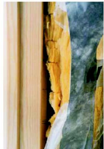
Mangelhafte Ausführung der Luftdichtheitsschicht. Die Folie hat sich vom Rahmen gelöst.
